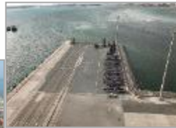
2017 : RSGT expansion project
